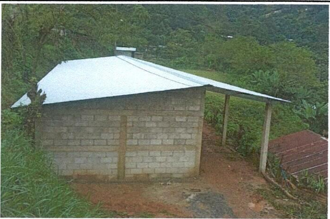
Foto 3: Remodelación de aula tipo portico
