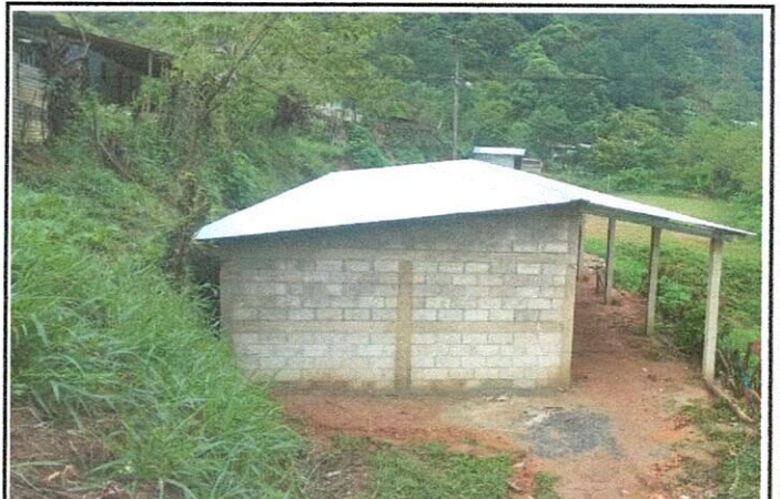
Foto 4: Remodelación de aula tipo portico
