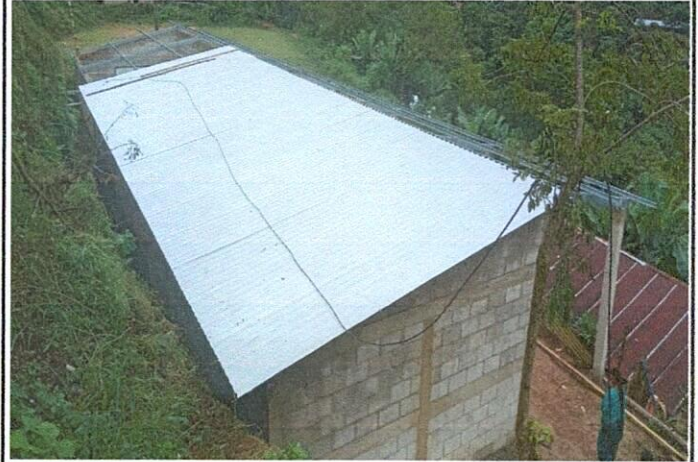
Foto 2: Remodelación de aula tipo portico
